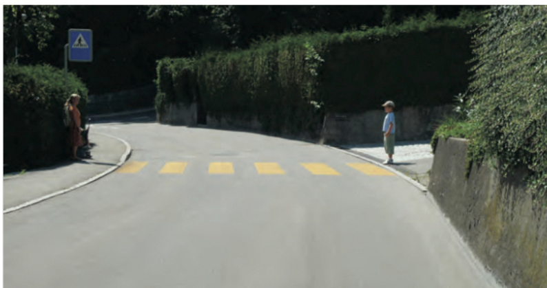
Immagine 7: il bambino a destra ha una pessima visibilità e sta attraversando le strisce pedonali nel punto sbagliato (fonte: ©verkehrsteiner ag Rolf Steiner).
